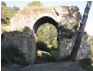
Puente Califal sobre el Guadiato
