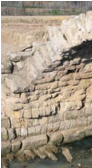
Puente sobre el arroyo Cantarranas
