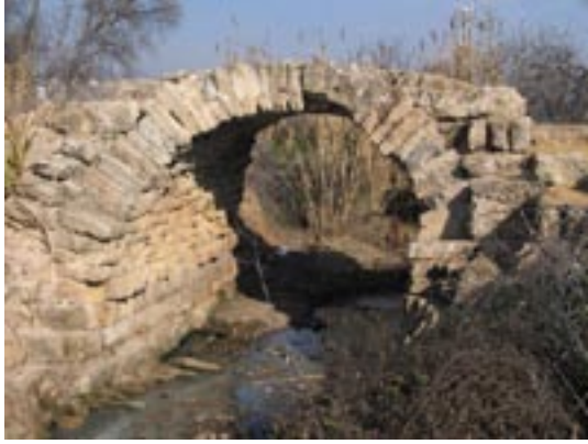
Puente sobre el arroyo Cantarranas
