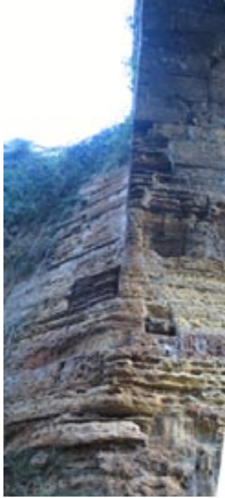
Puente del Aljibillo
