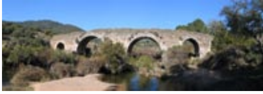
Puente Sobre el rio Guadanuno
